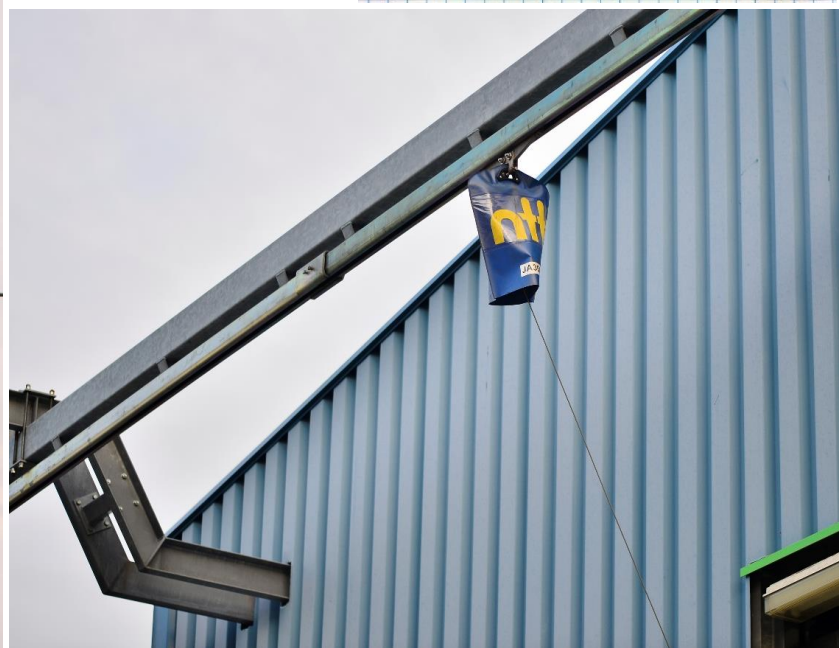
Wetterschutzhauben bei Verladestationen für Kesselwagen und Tankzüge
