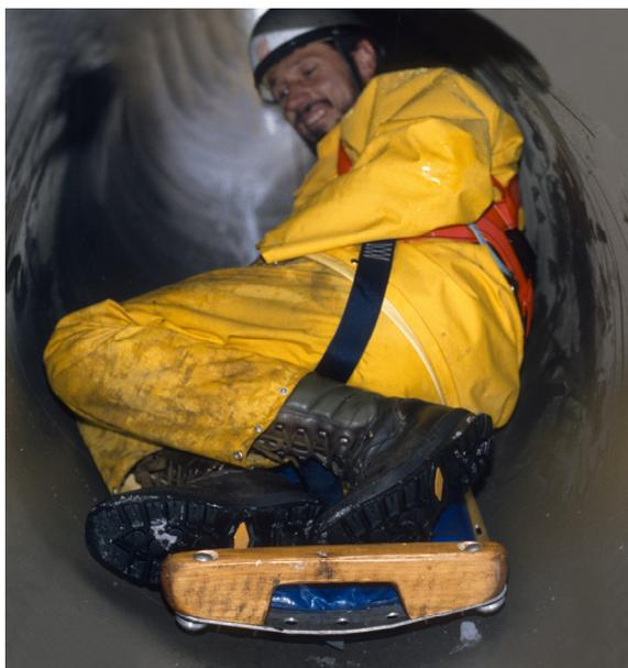
Auf dem Rohrleitungs– Befahrwagen seitlich liegend.
