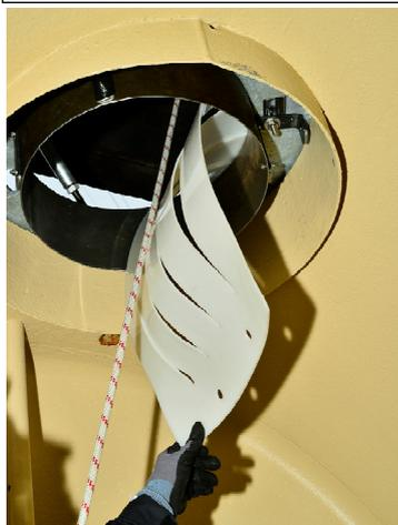
Gleitplatte geschlitzt in einem Mannloch  $\varnothing$  400 bei freier Höhe darüber von 400 mm!!!
