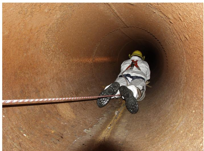
Befahrung der genieteten, stark korrodierten Druckrohrleitung eines Wasserkraftwerks; Neigung bis zu 45°. P7022522.JPG
