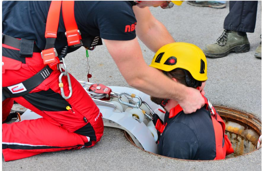
Retten aus einem engen Schacht mit dem teilflexiblen Rollen- Seilschutz, Gleitplatte und Flaschenzug mit Mehrfachwirbel ohne Dreibein etc..
