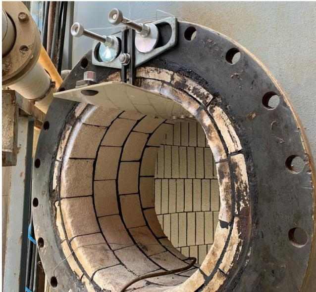
Befestigung am Mannlochstutzen oben zur Umlenkung der
