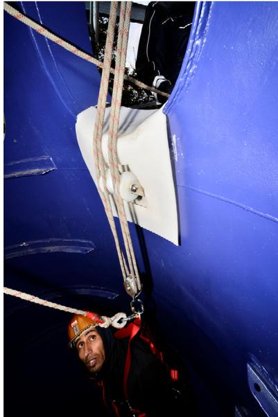
Rollensatz 5- rollig mit gewinkelter Gleitplatte an einem Behälter innen.
