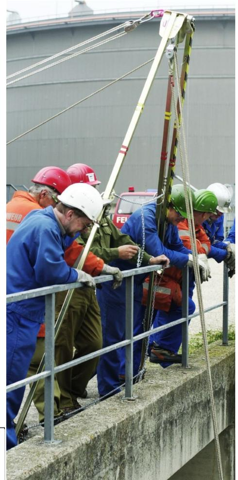
Zweibein zurückgehängt mit angelegtem Pendelbein; Retten mit dem Flaschenzug in direkter Anwendung aus einem Rohrleitungsschacht.
