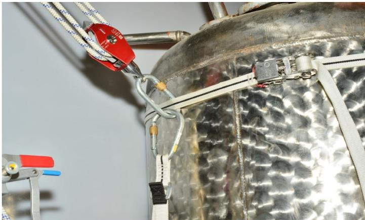
Abhängung des Flaschenzugs mittels Spannband um den Behälter.
