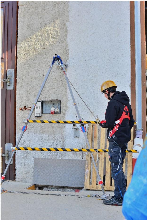
Geschlossene Durchgangssperre als kollektive Schutzmaßnahme.
