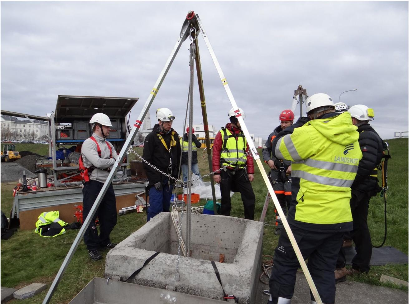
Dreibein mit asymmetrisch ausgeschwenktem Pendelbein aufgrund des hohen Schachtrahmens aus Beton (ältere Bauweise mit Ketten).
