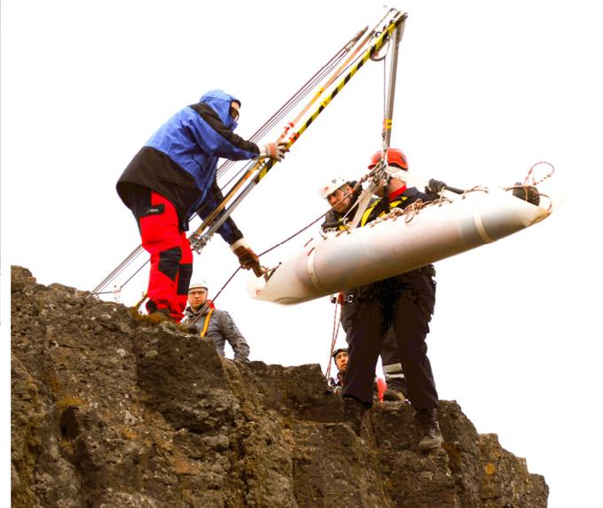
Flaschenzüge indirekt und direkt (zum Zurückhängen) am 2- / 3- Bein bei großer Hubhöhe in einem Steinbruch.
